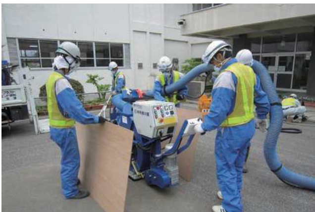
汚染されたアスファルト表面を取り除いています
