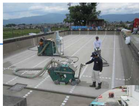
プールの底の除染を行っています
