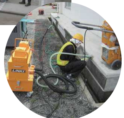
建物の表面の除染を行っています
